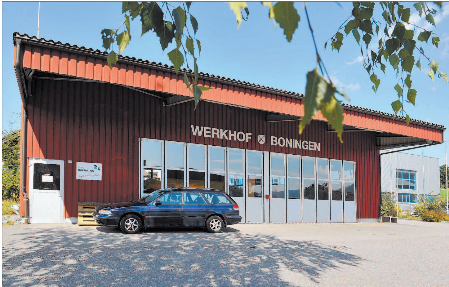
REGIONALE NUTZUNG 2007 hat die Eug-Infra AG den Werkhof in Boningen gemietet. Nun soll das Angebot ausgebaut werden. BRUNO KISSLING
