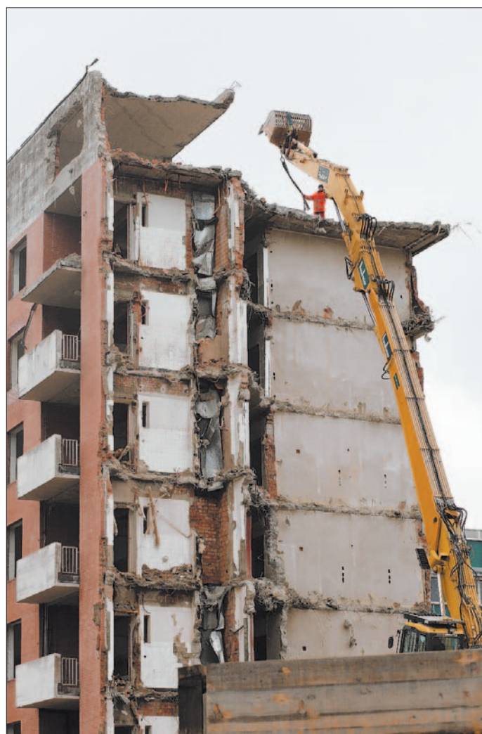
UNERBITTLICH NAGT DER BAGGERZAHN Spektakuläre Abbrucharbeiten am alten Bettenhaus des Kantonsspitals Olten. HR. AESCHBACHER
