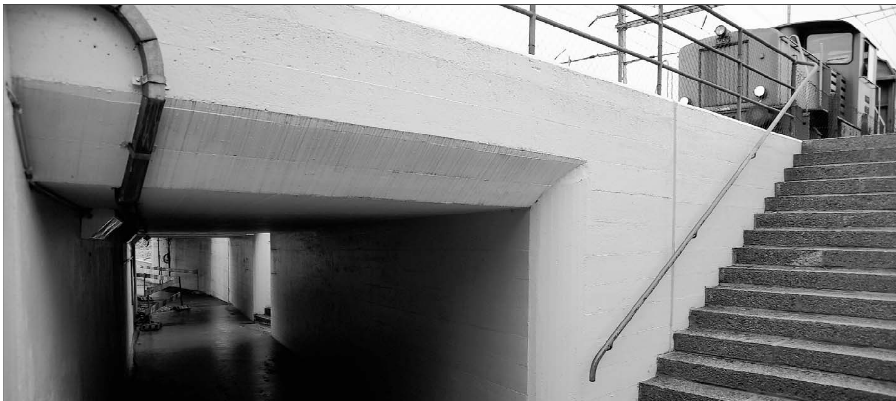
BAHNUNTERFÜHRUNG WANGEN Für die öffentliche Sicherheit in Wangen, findet der Leserbriefschreiber Willy Schönenberger, sollte mehr getan werden. Das Postulat, das speziell die Bahnunterführung betrifft, findet er dagegen, sei unnötig. uw
