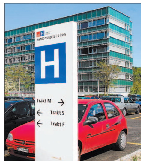
KANTONSSPITAL OLTEN Parkmisere soll ab 2012 ein Ende haben. BKO
